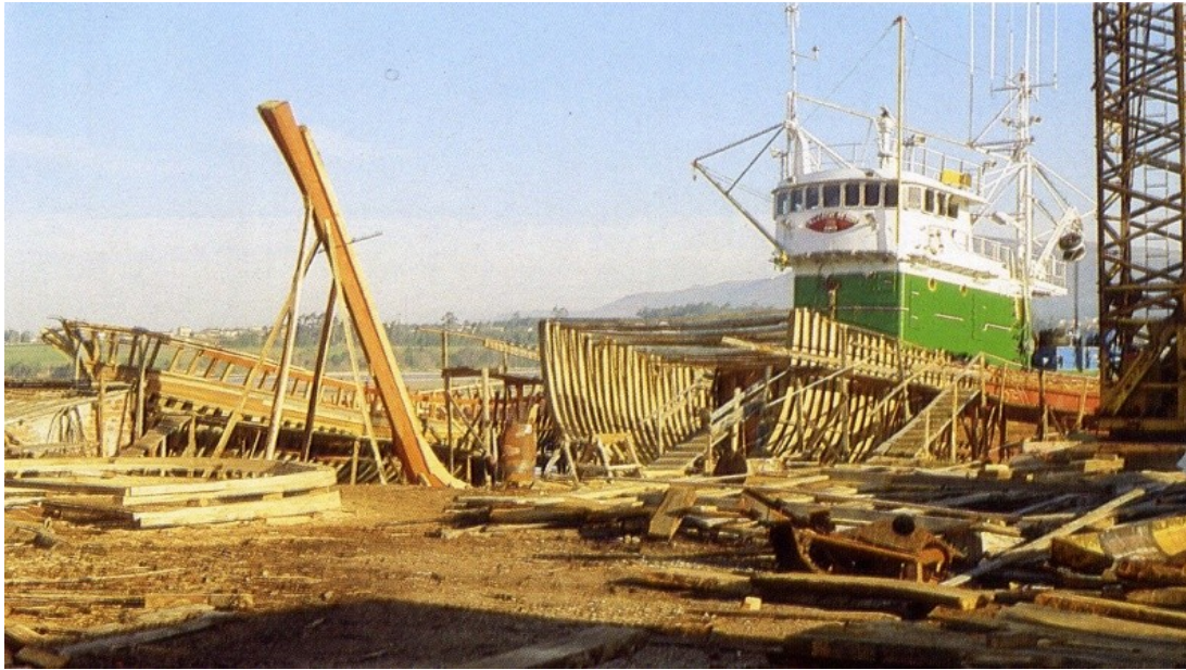
Figura 20: Estaleiro Xesus Nécega. Prolongación do barco Villa Real de Orio. Esta obra fíxose en varios barcos. Ao fondo, noutra grada vese o Agarimo a medio construír.
