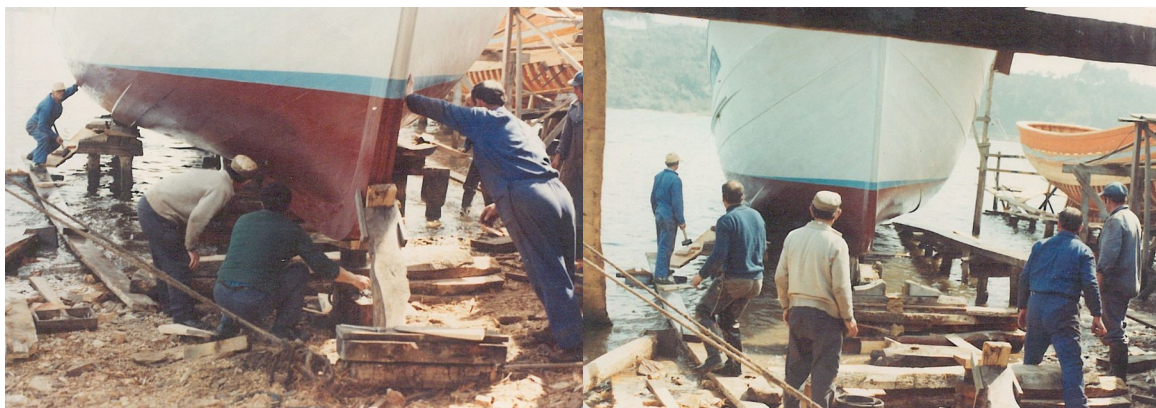
Figura 29. Nestas imaxes vese un obreiro manexando coa man o gato hidráulico e outro cunha maza na man listo para soltar as cuñas que aguantan o barco. Un puntal que se apoia no branque (proa) usase para que cando baixan o gato faga de empuxe e axuda a empurrar o barco. Todo isto ten facerse con precisión. Ao mesmo tempo hai un barco para remolcalo, axudando a baixalo e levalo para o porto.
